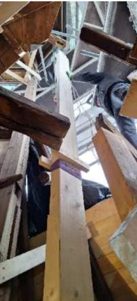
Im Turmhauptdach, der Laterne und dem Laternendach wurden über 90% der Balken (ca. 13 m<sup>3</sup> Holz) durch die Firma Portack & Grille ausgetauscht. Ebenso wurde die komplette Dachschalung erneuert und anschließend von der Dachdeckerei Voit nach den Vorgaben des Denkmalschutzes neu mit knapp 6,5 Tonnen Naturschiefer gedeckt.
